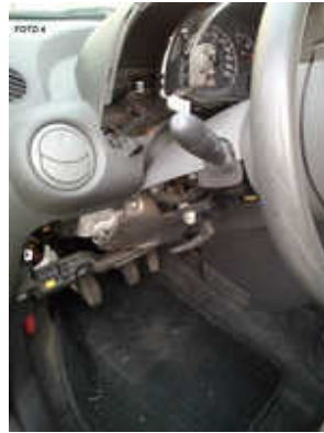
1 : derrière le compteur de vitesse ; 2 : le boîtier à fusibles
